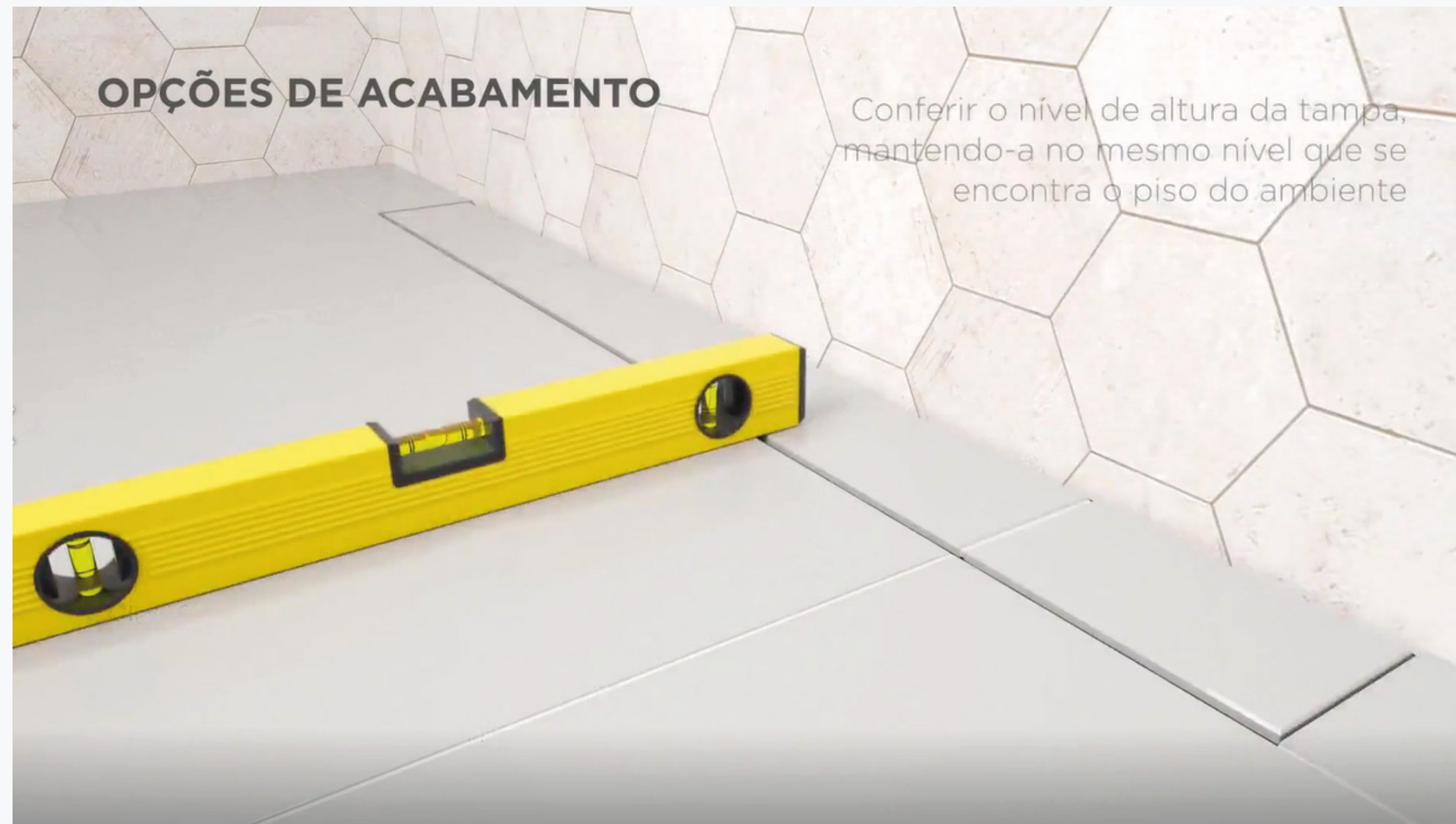
Figura 19 - Nível de altura da tampa
