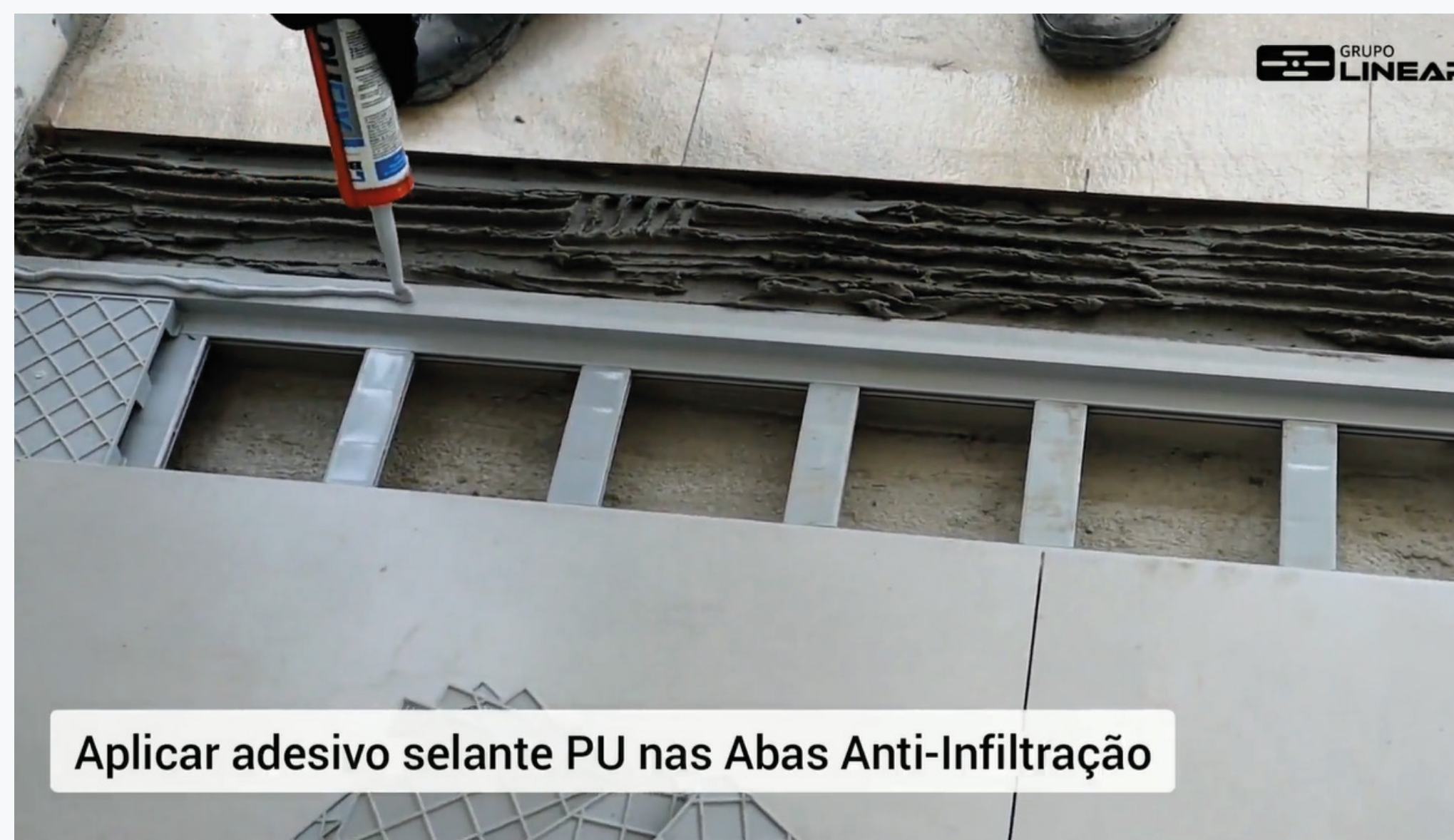
Figura 22- Aplicação do adesivo selante PU
