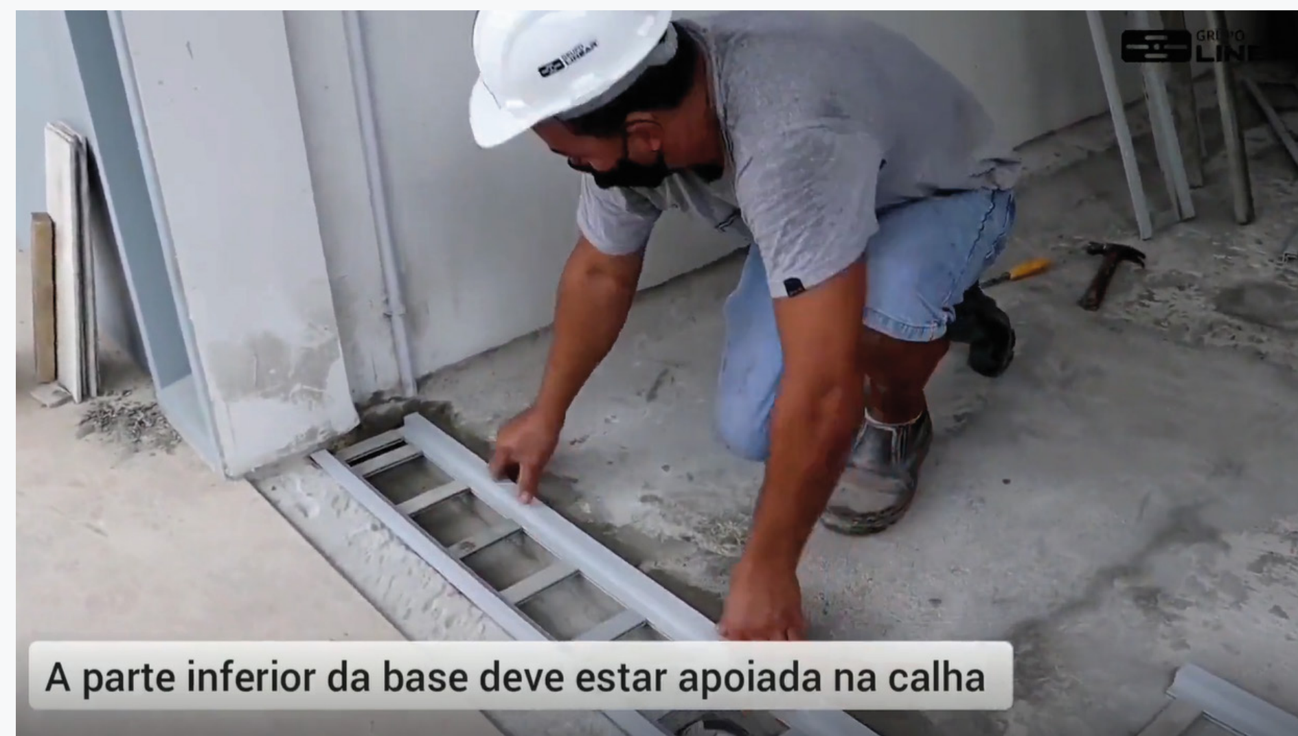
Figura 21- Instalação da base Infinity Plus
