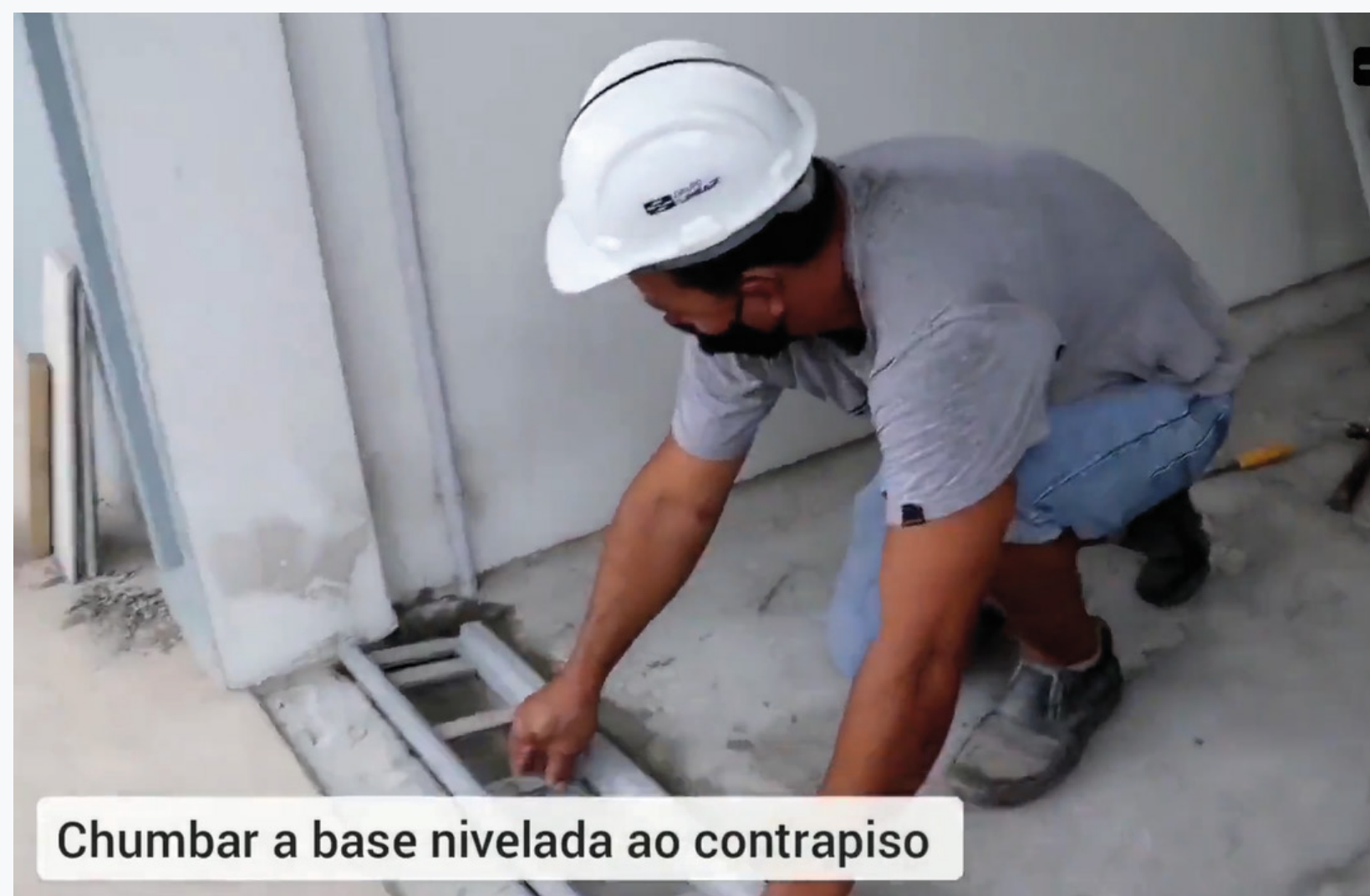
Figura 20- Nivelamento da base Infinity Plus
