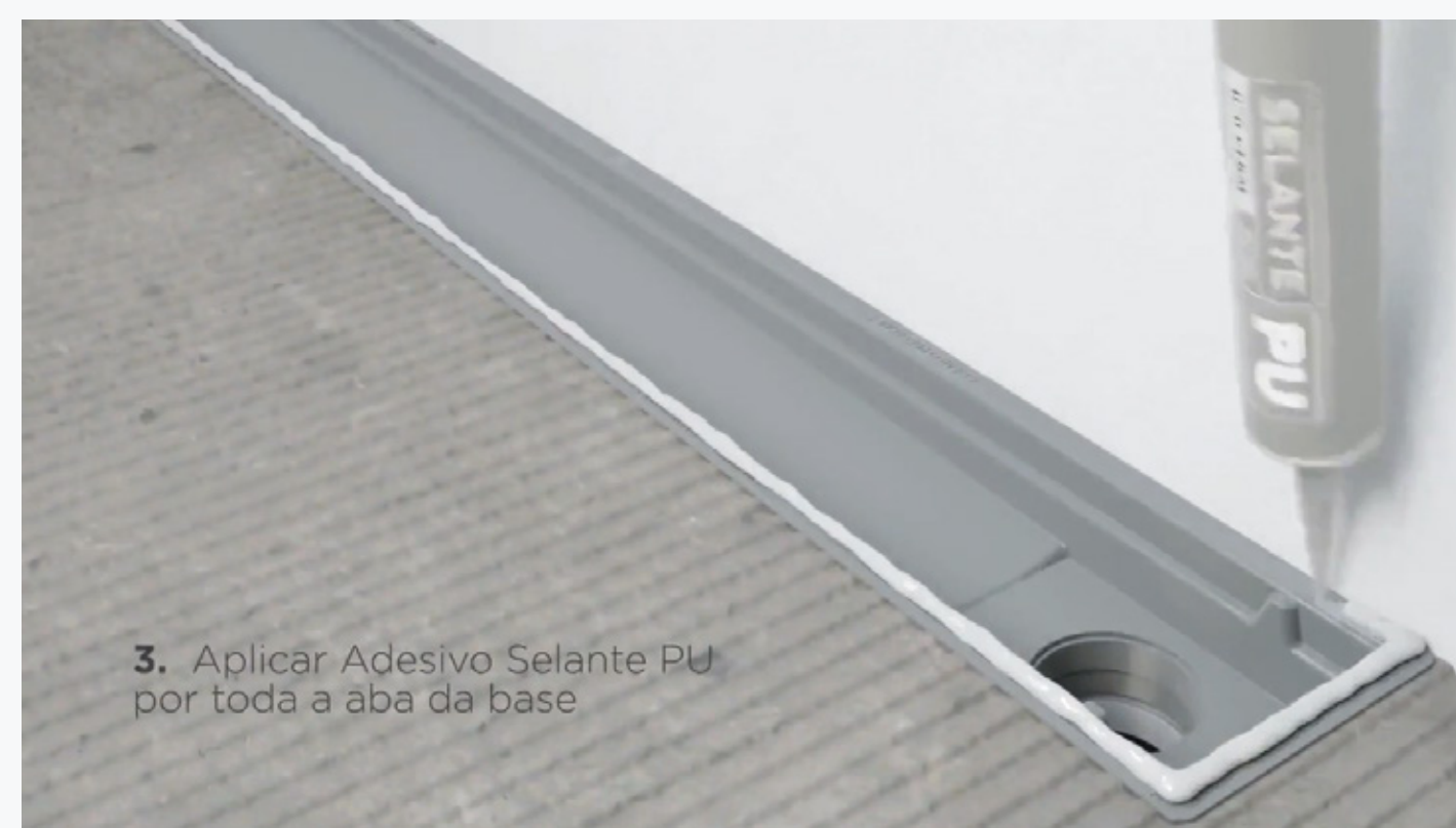
Figura 16 - Aplicação do Adesivo Selante PU
